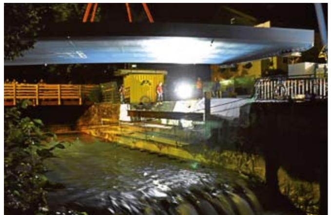
Einhub des 60 Tonnen schweren Brückentragwerkes.
