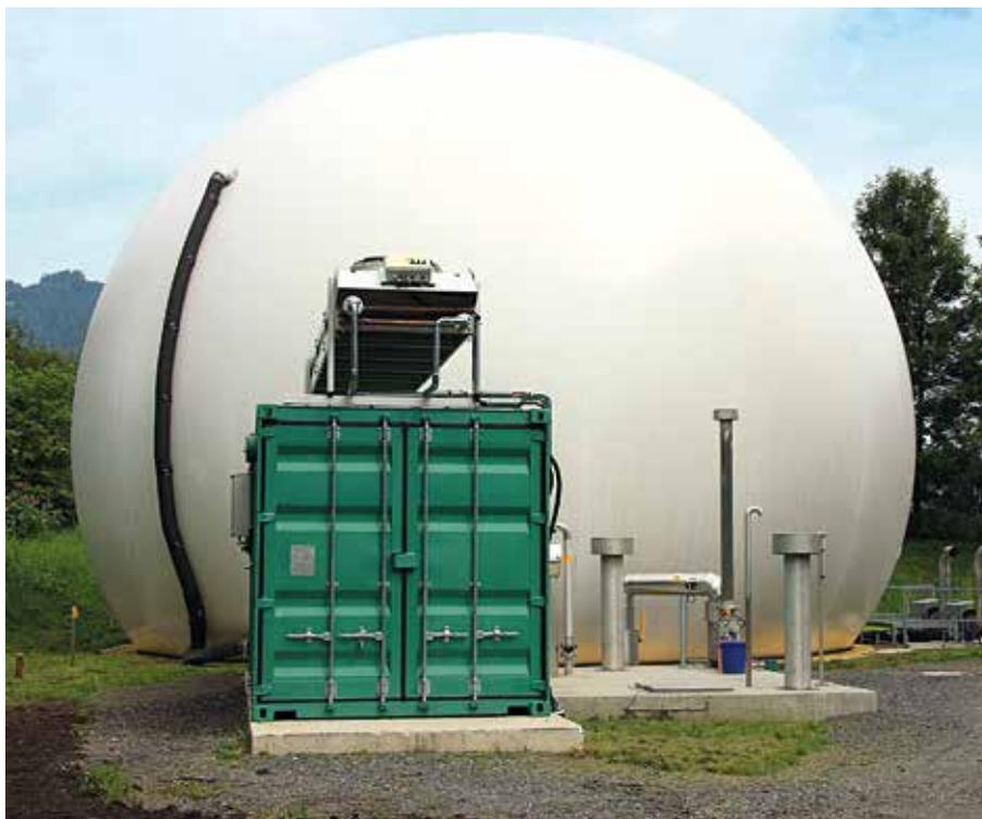
Die Anlage besteht unter anderem aus diesem Speicher, der 1.150 m<sup>3</sup> Biogas fasst. Das Tauern Spa Kaprun heizt seine Wasserbecken mit Energie aus der Biogasanlage.
